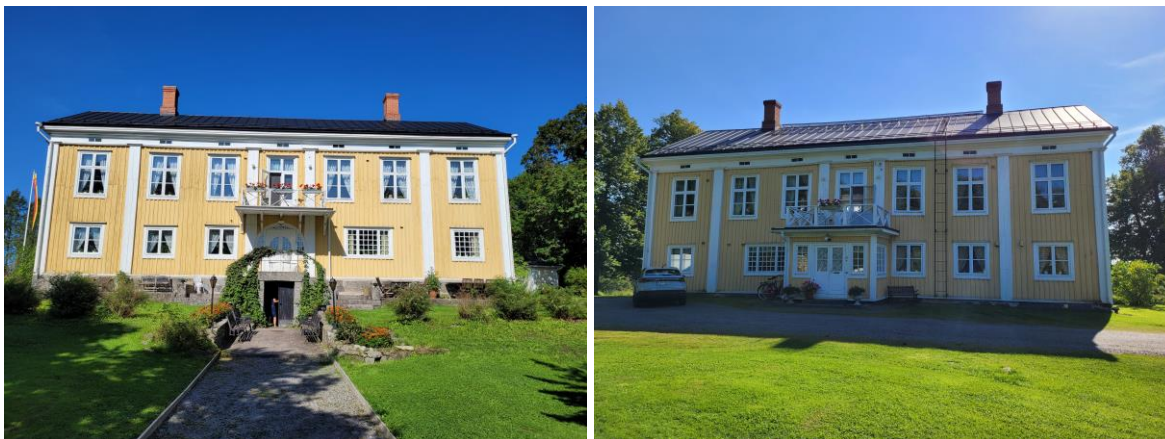
Bild 30 Huvudbyggnadens fasad mot sydväst (till vänster) och mot nordost (till höger).
