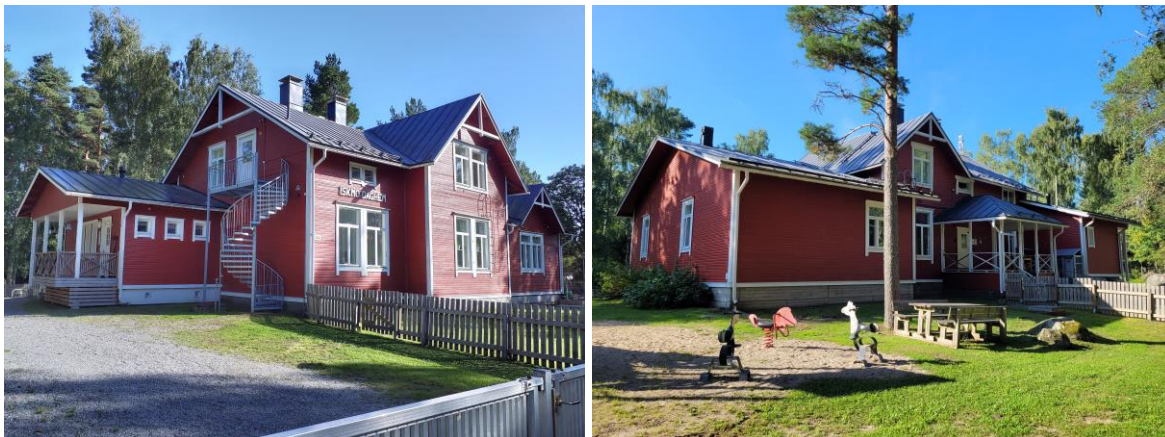
Bild 46 Fasaderna till Iskmo daghem och före detta skola sett från norr (till vänster) och söder (till höger).
