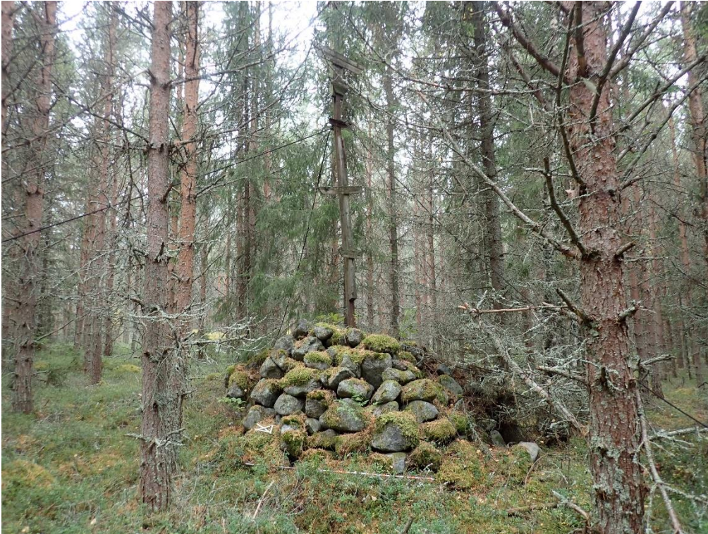
Kuva 2. Fjärdskäretin saarella on näyttävä kiviraunio. Tämä raunio on voimalinjaylvään perustus.
