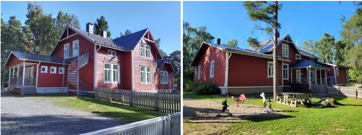
Kuva 46 Iskmon päiväkodin ja entisen koulun julkisivut pohjoisesta (vasemmalla) ja etelästä (oikealla) katsottuna.
