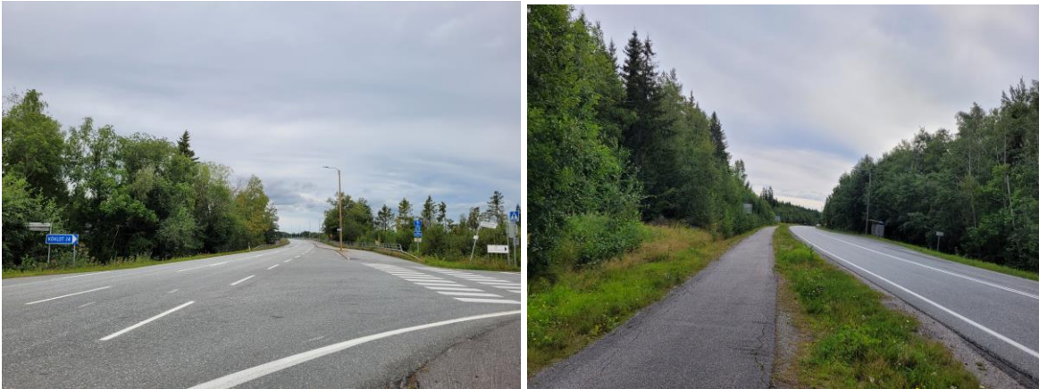
Kuva 6 Alskatintie jatkuu selvitysalueelta Raippaluodon sillaksi (vasemmalla). Alskatintien varrella on molemmin puolin runsaasti puustoa ja näkymälinjat kulkevat pitkin tietä (oikealla).
