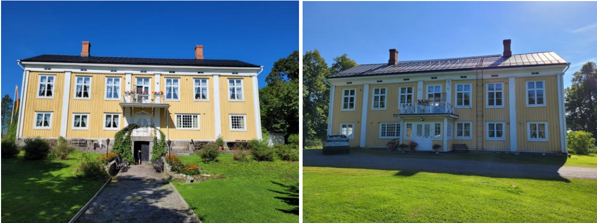
Kuva 30 Päärakennuksen lounaisjulkisivu (vasemmalla) ja koillisjulkisivu (oikealla).
