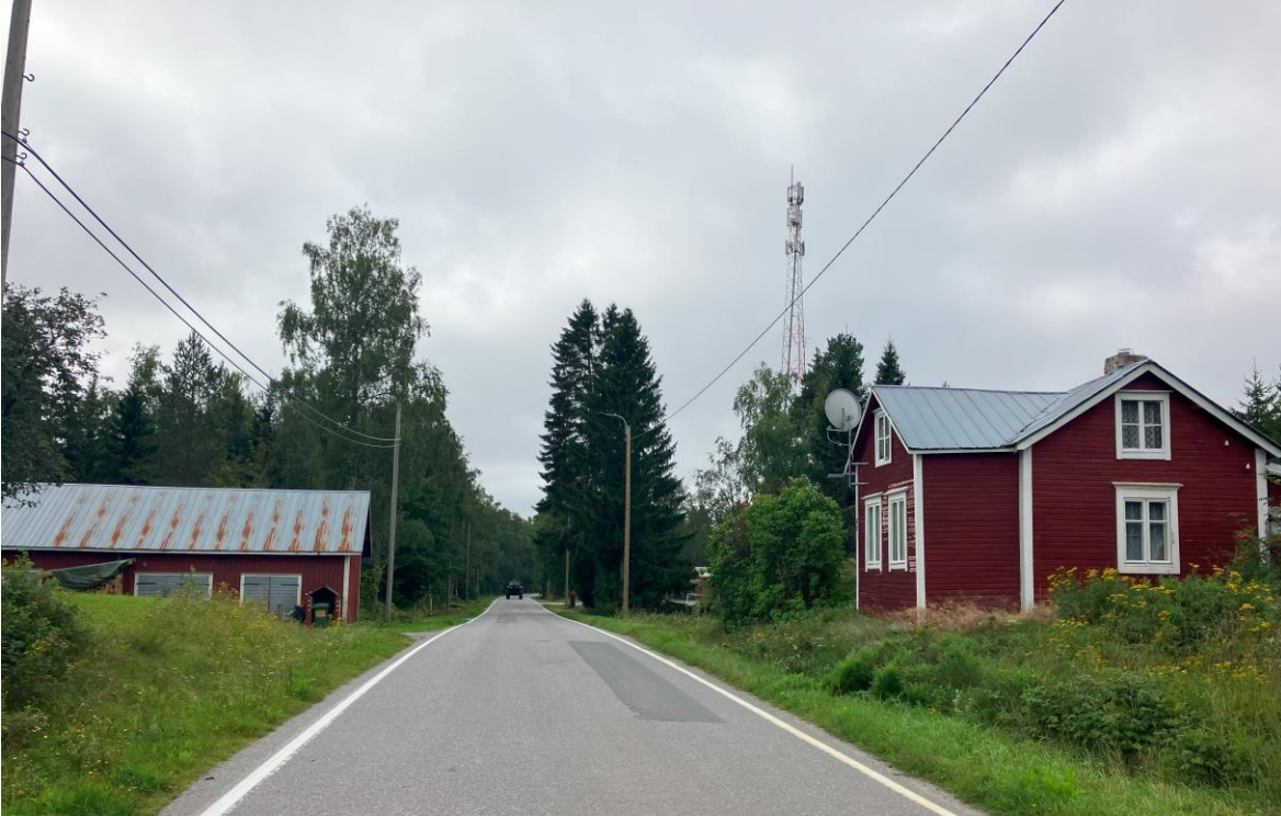
Kuva 24 Iskmontien varrella sijaitse puhelinmasto näkyy tien varrella.
