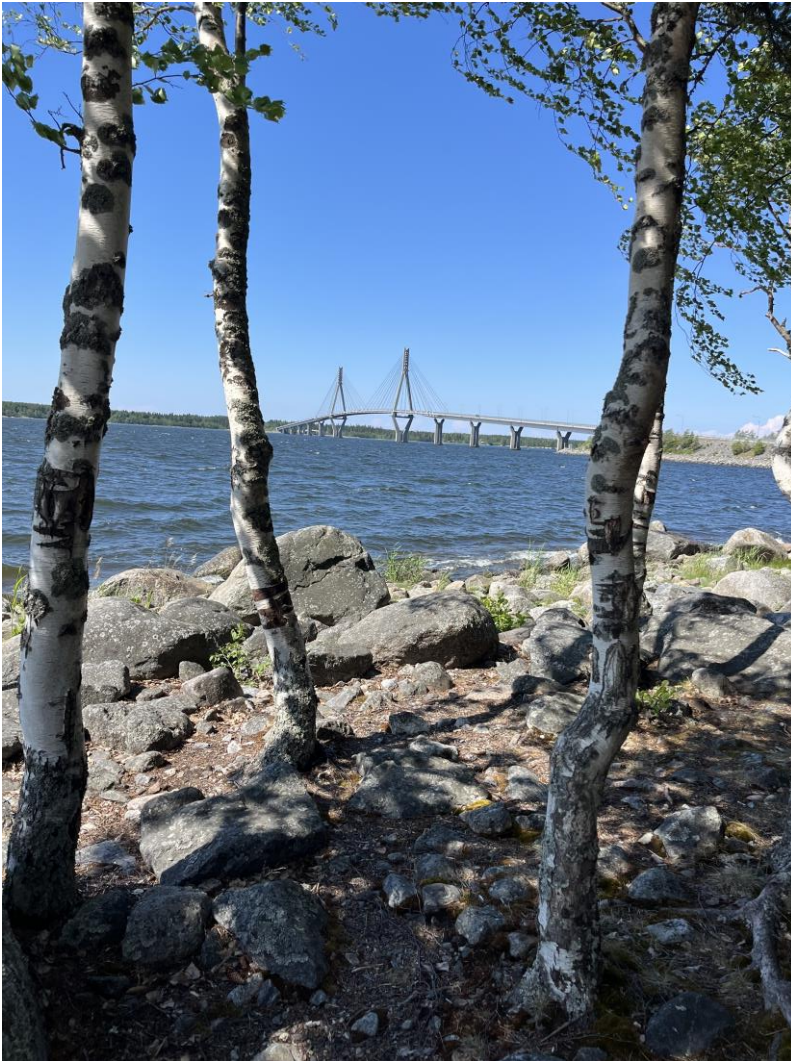
Kuva 25 Raippaluodon silta Fjärdskäretistä kuvattuna.
