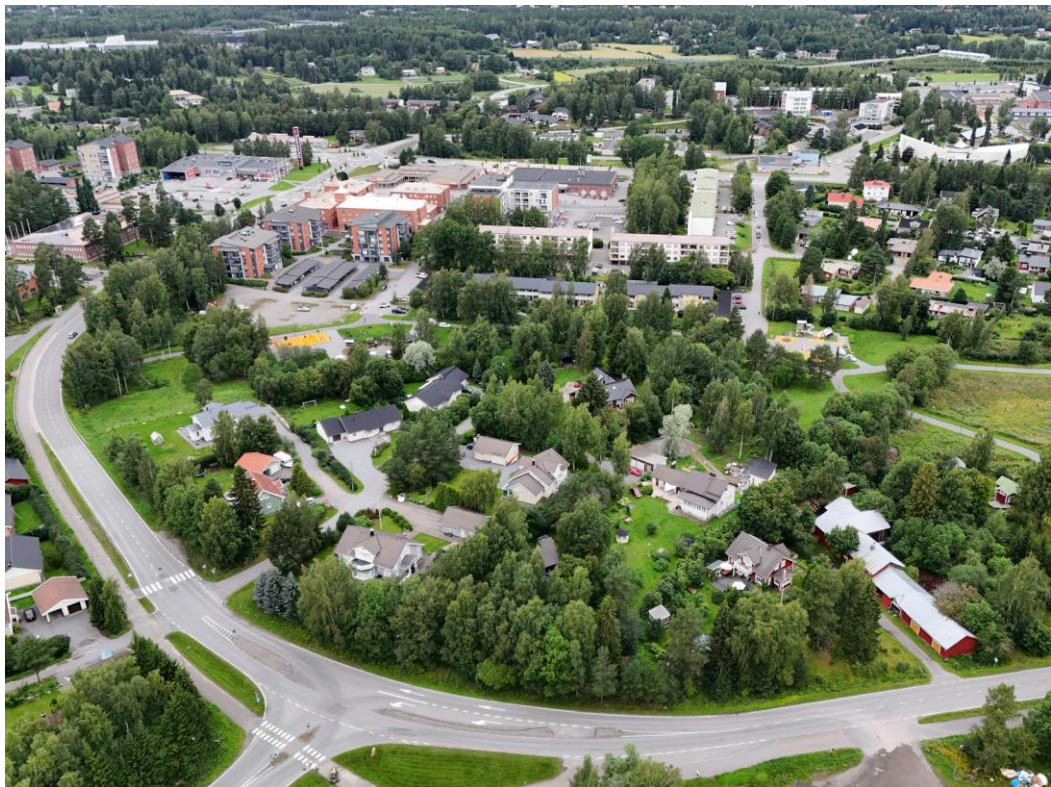
Bild 2. Snedbild över detaljplaneområdet sett mot norr.
