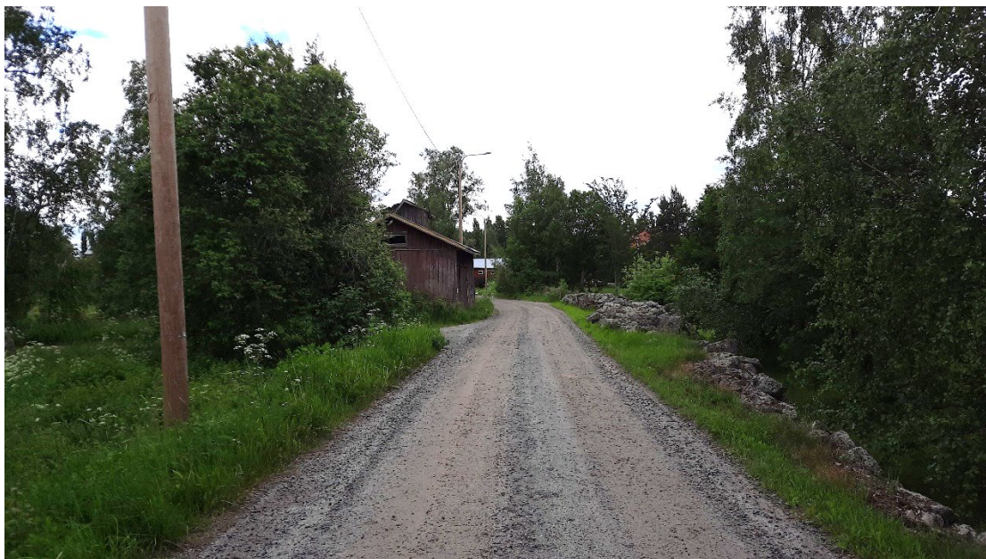
Bild 11. Fotografi av Båskastået i sydlig riktning och rian som i dagsläget är riven.
